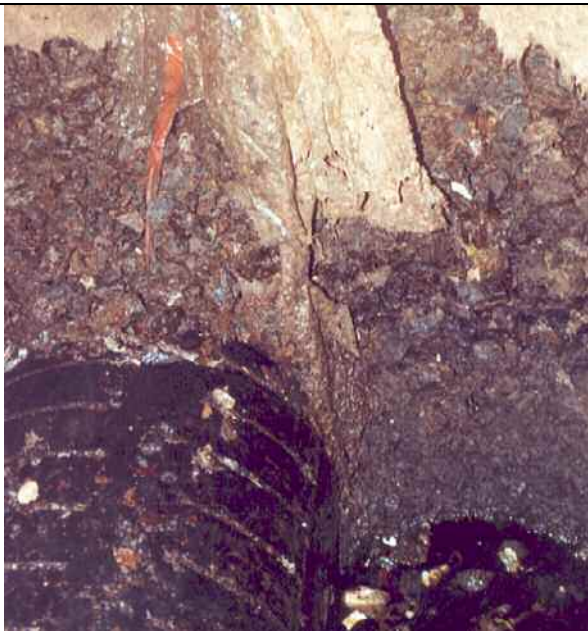
Abbildung 6: Kiesüberdeckung des freigelegten Altrohrs
