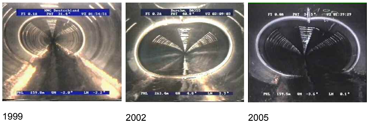
Abbildung 1: Entwicklung der Deformationen in der Rohrleitung
