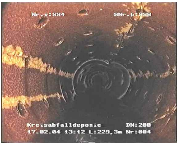
Abbildung 9: Querschnittsverengung im Stz-Rohr DN 200
