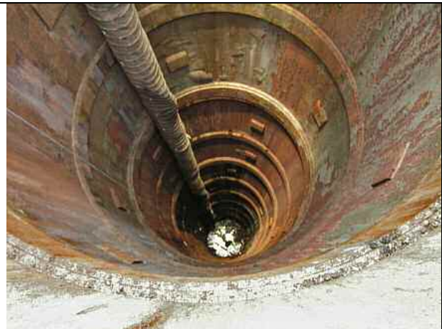
Abbildung 5: Schacht mit Stahlrohrverbau
